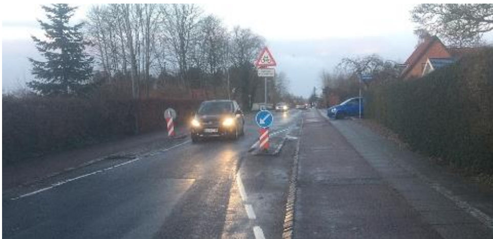
Figur 4 - foto fra besigtigelse.
